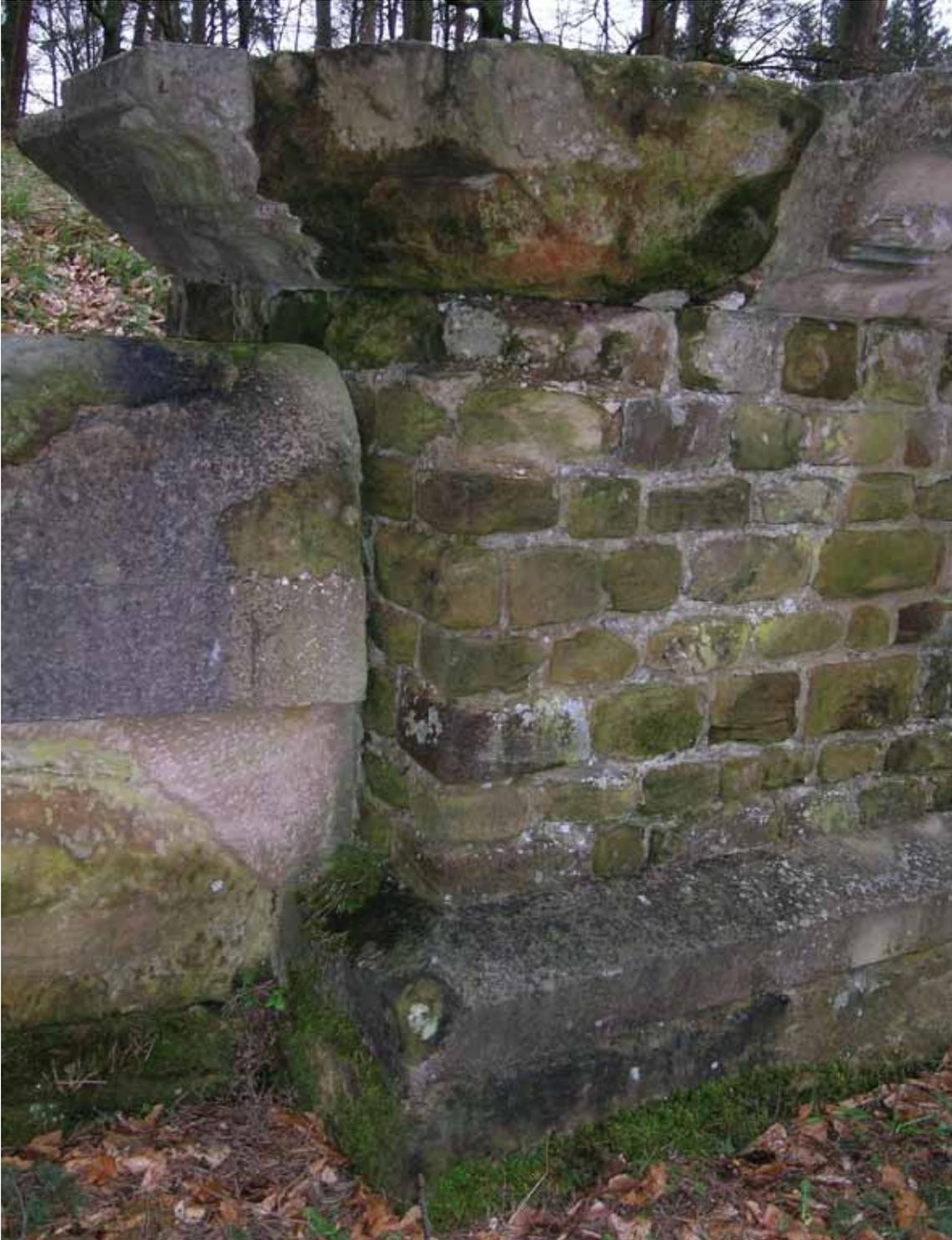
(Abb. 2) — Gravierende Bauschäden am Altar und dem Altargesims im Sommer 2012
