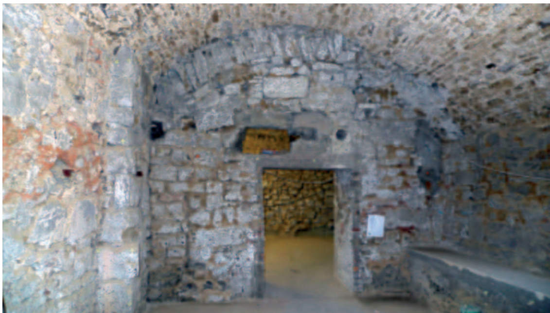
(Abb. 5) — Der ehemalige Verbindungsweg zwischen Niederstegasse und Altmarkt. In Bildmitte ein Torbogen (vermutlich des 16. Jh.), links und rechts davon zwei ehemalige Aussenfassaden von Gebäuden, die den Weg flankierten (Foto C. Bis-Worch, CNRA).
