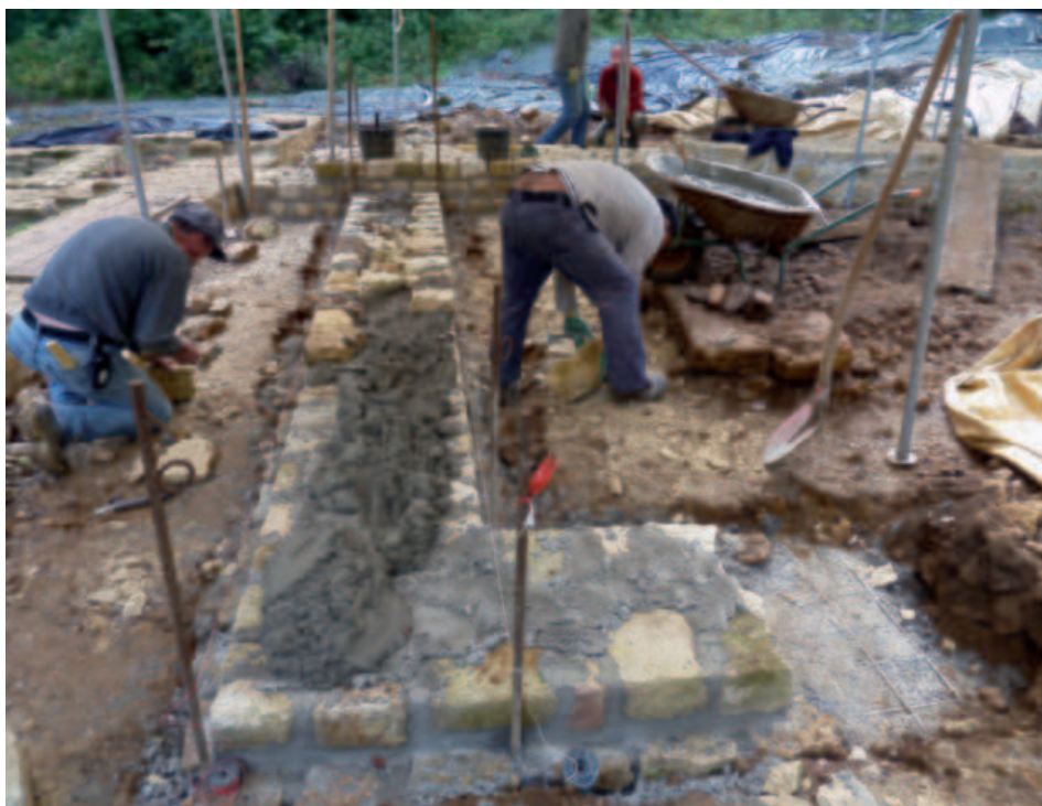
(fig. 4) — ...et liés avec un mortier à base de chaux (photo. J. Damota).
