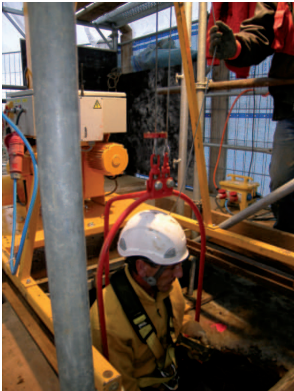
(Abb. 19) — Der Schutzbau mit Sessellift und Seilwinde: eine Sicherungsmaßnahme bei der Arbeit in großer Tiefe. Ein Arbeiter fährt gerade in den Brunnenschacht ein (Foto F. Dövenér © CNRA-MNHA).
