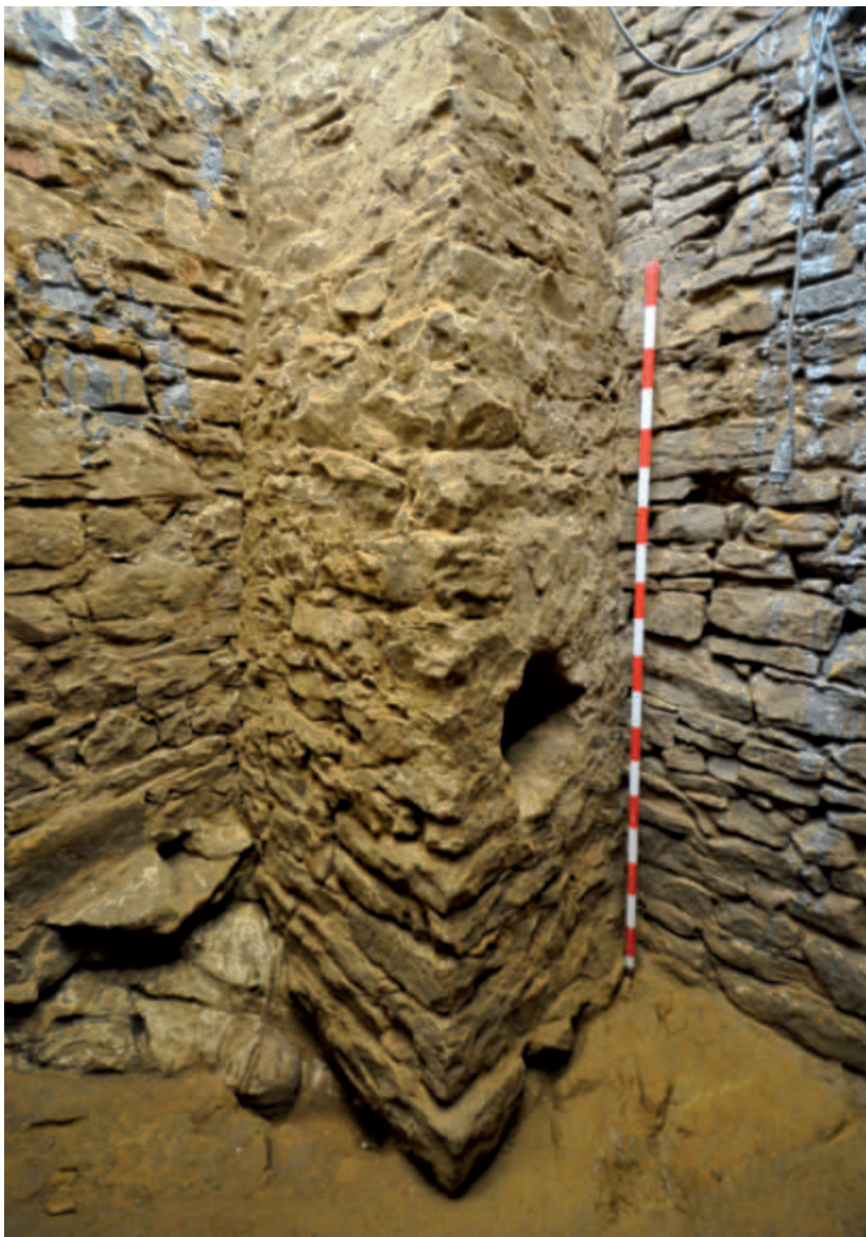
(fig. 3) — Vue du conduit d'aération dans la cave (photo © Archeodunum SA).
