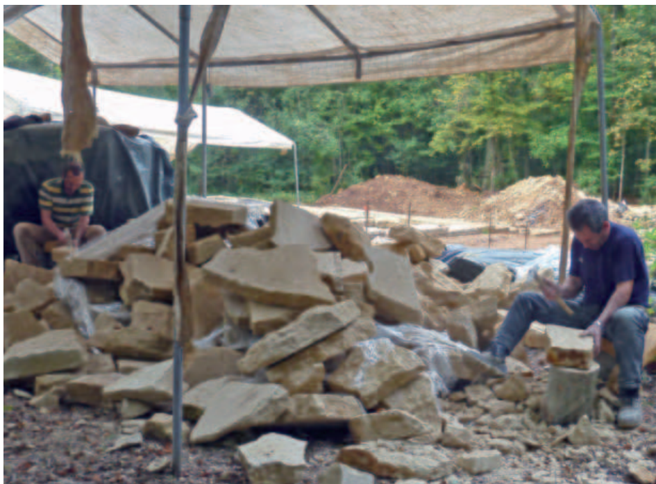
(fig. 3) — Les moellons sont taillés à la main dans le calcaire à Polypiers du Bajocien inférieur utilisé à l'époque... (photo. J. Damota).
