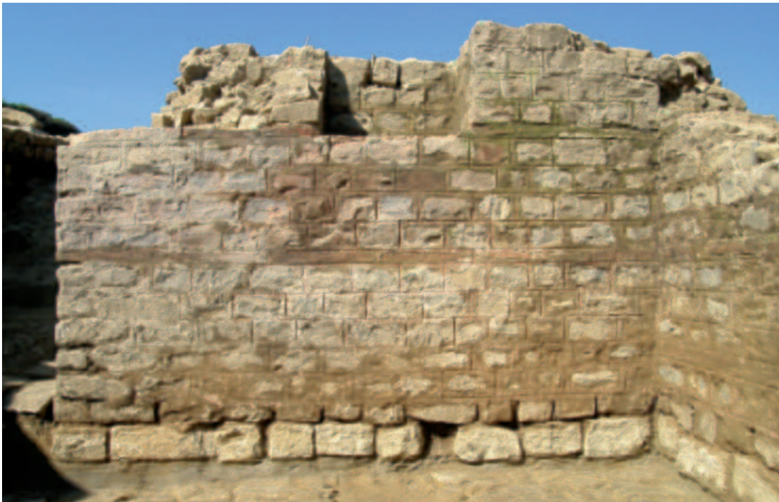
(Abb. 8) — Die schmale Nordwand von Keller 2 mit Verputzresten und Fugenstrich (Foto F. Dövenner © CNRA-MNHA).
