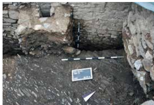
( Abb. 13 ) — Gemauerter Schacht (Foto C. Colling © MDG).
