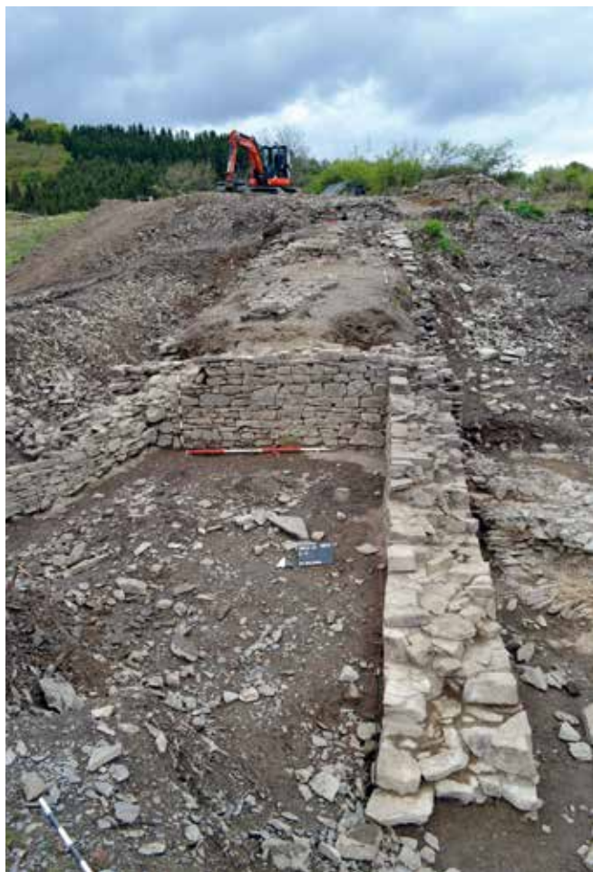
( Abb. 6 ) — Baukomplex zwischen dem oberen Burgbering und der Privatparzelle (Foto C. Colling © MDG).
