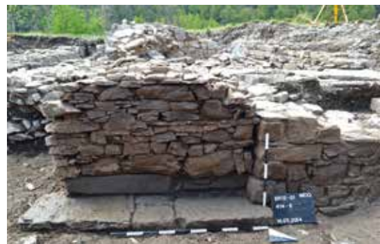
(Abb. 16) — Nachträglich verfüllter Kellerraum (Foto C. Colling © MDG).
