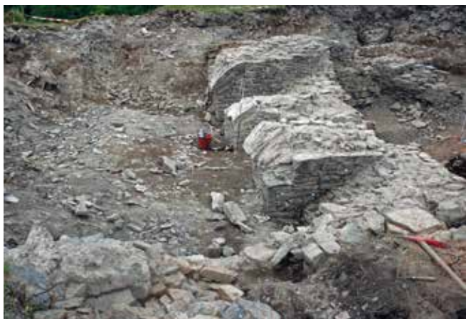
( Abb. 11 ) — Gewölbekeller mit Gewölbeansätzen und Lichtschächten (Foto C. Colling © MDG).
