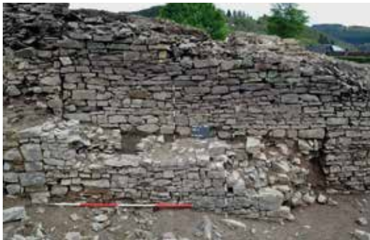
(Abb. 7 u. 8) — Westliche Außenmauer mit Resten einer vorausgegangenen Bebauung (Foto C. Colling © MDG).
