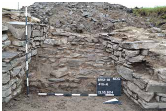
( Abb. 12 ) — Einer der Lichtschächte des Gewölbekellers (Foto C. Colling © MDG).
