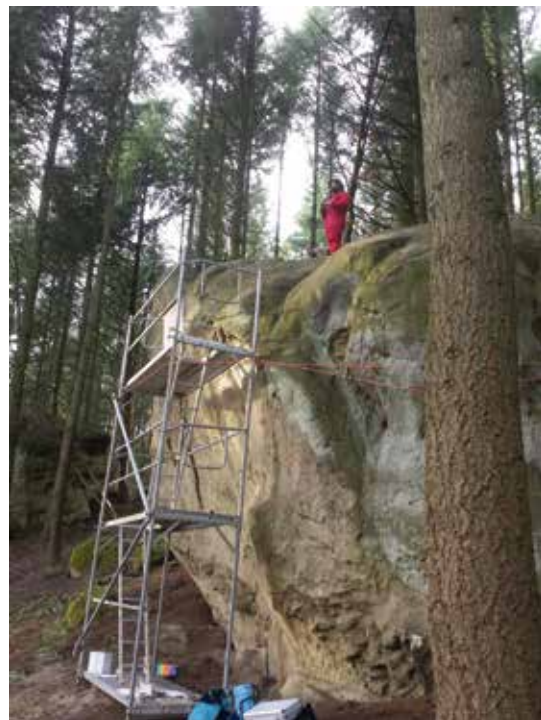
(Abb. 2) — Für den Zeitraum der Untersuchungen wurde die Südwand eingerüstet, da das stark abschüssige Terrain die Arbeit von der Leiter gefährlich gestaltete (© Friederike Funke 2016).
