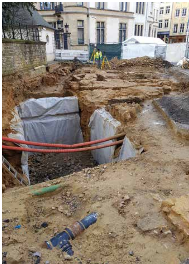
(Fig. 4) — Luxembourg-Rue de l'Eau. Dans le but de sauvegarder le maximum de structures découvertes lors des fouilles, cette belle cave médiévale a été rebouchée avec de la terre et le tracé de la canalisation adapté (photo CNRA).
