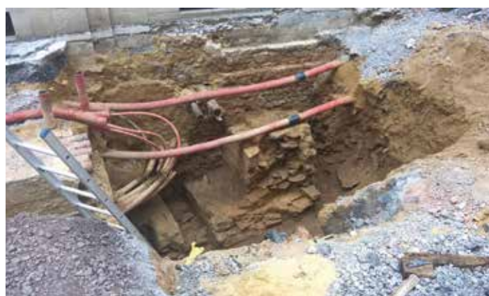
(Fig. 9) — Luxembourg – Rue de l'Eau : La construction de ce petit pan de mur est fortement comparable avec la construction découverte dans la Niklosgaass en 2008 et qui peut être interprétée avec certitude comme faisant partie d'un pont levais. Etant donné qu'il s'agit probablement du dernier témoin de l'ancienne basse-cour tardive du château, les responsables de la Ville de Luxembourg ont accepté de sauvegarder les structures en les intégrant dans le regard technique prévu à cet endroit (photo CNRA).
