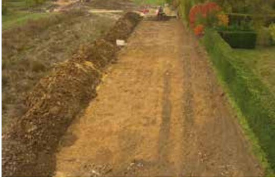
(Abb. 25) — Ausbruchgräben der Streifenhausbebauung, Mamer-„op Bierg II – Fläche V“, Blick gegen West (Foto 571, M. Paulke © CNRA-MNHA).
