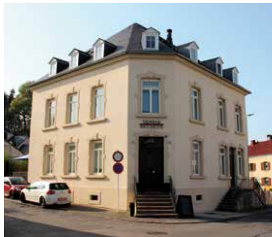
(fig. 1) — La nouvelle apparence de l'ancien Café-Hôtel Simon-Calteux dans le centre de Dalheim (photo. N. Sand © CNRA).
