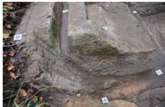
| (Abb. 6) — Linker „Schrotgraben“ des Hauptblocks (Foto M. Paulke © CNRA).
