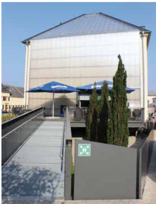
(fig. 2) — Vue de la façade sud-ouest avec sa peau en polycarbonate qui permet de collecter les rayons de soleil et de les transformer en chaleur (photo. N. Sand © CNRA).
