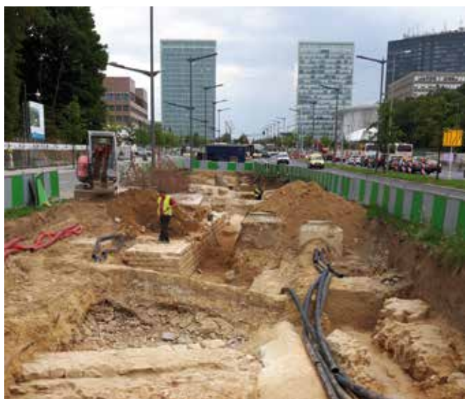
(Fig. 11) — Luxembourg – Fort Olizy : Vue sur les restes du Fort dégagés dans le contexte de la construction du Tram (photo C. Bis-Worch, CNRA).
