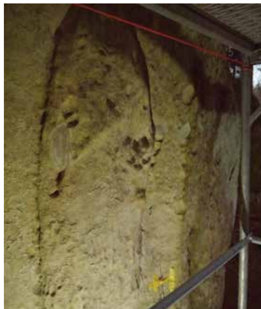
(Abb. 3) — Relief bei Nacht: die Streiflichtaufnahme verdeutlicht den schuppigen Zerfall der Oberfläche. Hier besteht dringender Handlungsbedarf (© Pieter Hellbach 2016).
