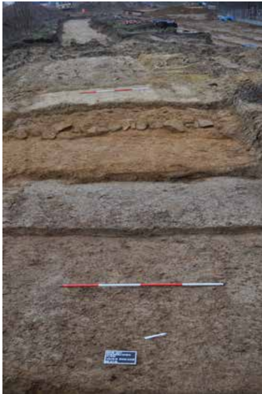
(Abb. 8) — Horizontal freigelegte Schichten der Straße. (Foto: Biver/Stead ArchéoConstruction, © CNRA).
