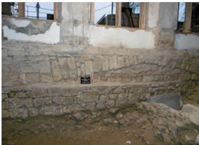
(Fig. 11) — Ville de Luxembourg – «Brasserie du City-Musée», vue sur différentes fondations dégagées lors de la fouille, appartenant à une phase antérieure aux bâtiments actuels (cliché: M. Delleré, Archéo Constructions).
