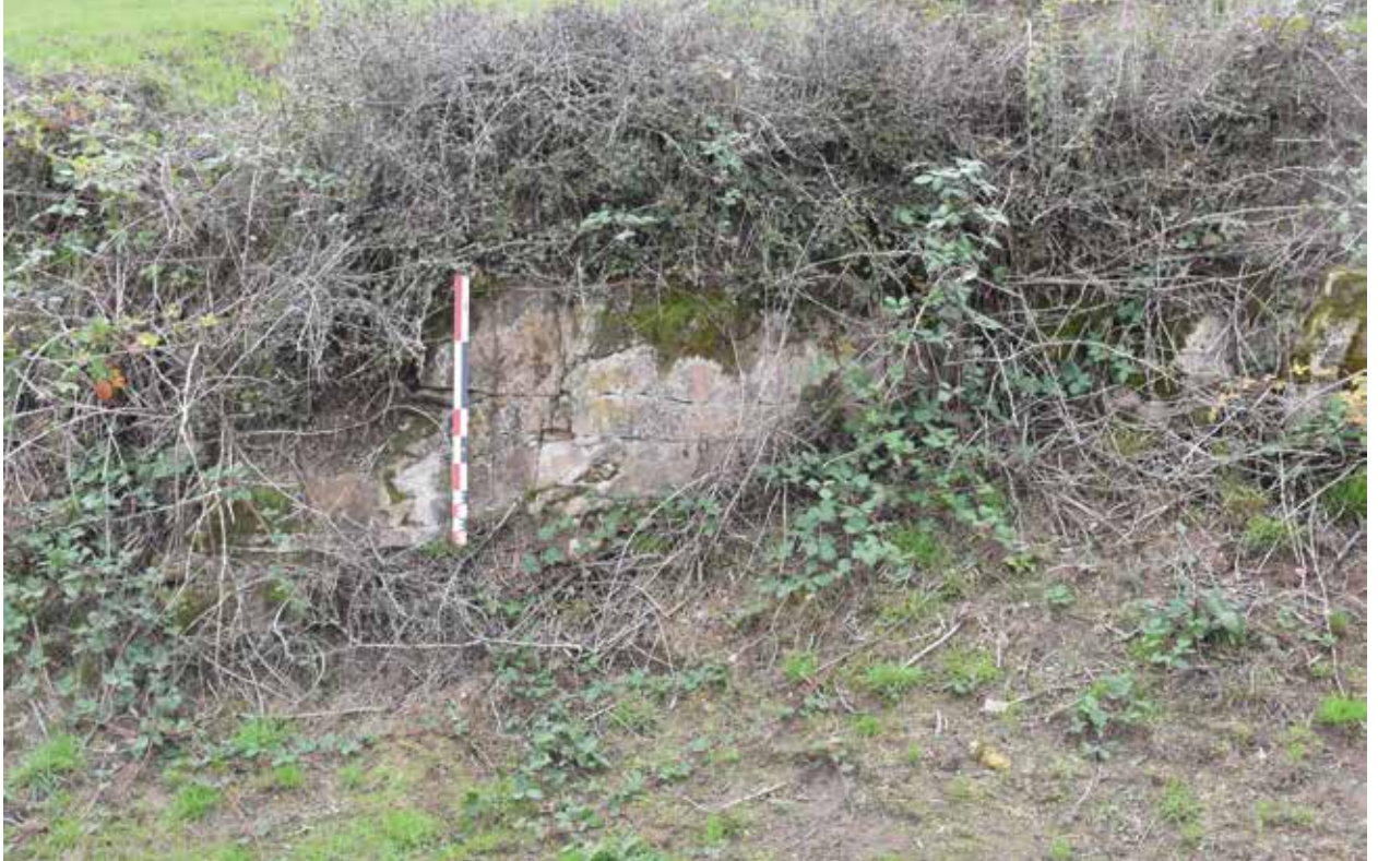
Fig. 5 — Front de taille dans une structure gréseuse localisée à proximité de l'occupation antique (Photo: N. Meunier/Archéo Constructions S.A.)
