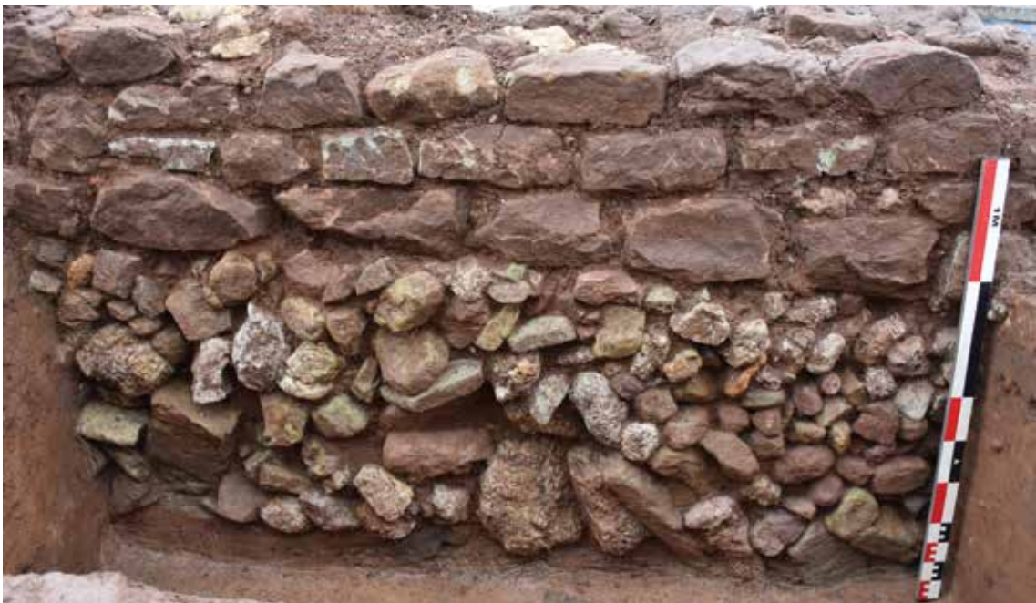
| (Fig. 4) — Parement externe de la fondation du mur occidental du bâtiment (Photo: N. Meunier/Archéo Constructions S.A.)
