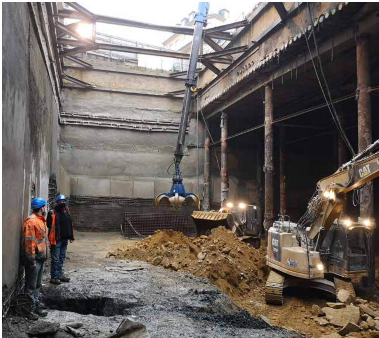
(Fig. 8) — Ville de Luxembourg – « futur extension du Parking Knuedler », les fouilles de la latrine (à gauche) réalisées en proche collaboration avec les travaux d'excavation du rocher naturel (à droite). L'image témoigne des conditions de travail inhabituelles (cliché : C. Bis-Worch).
