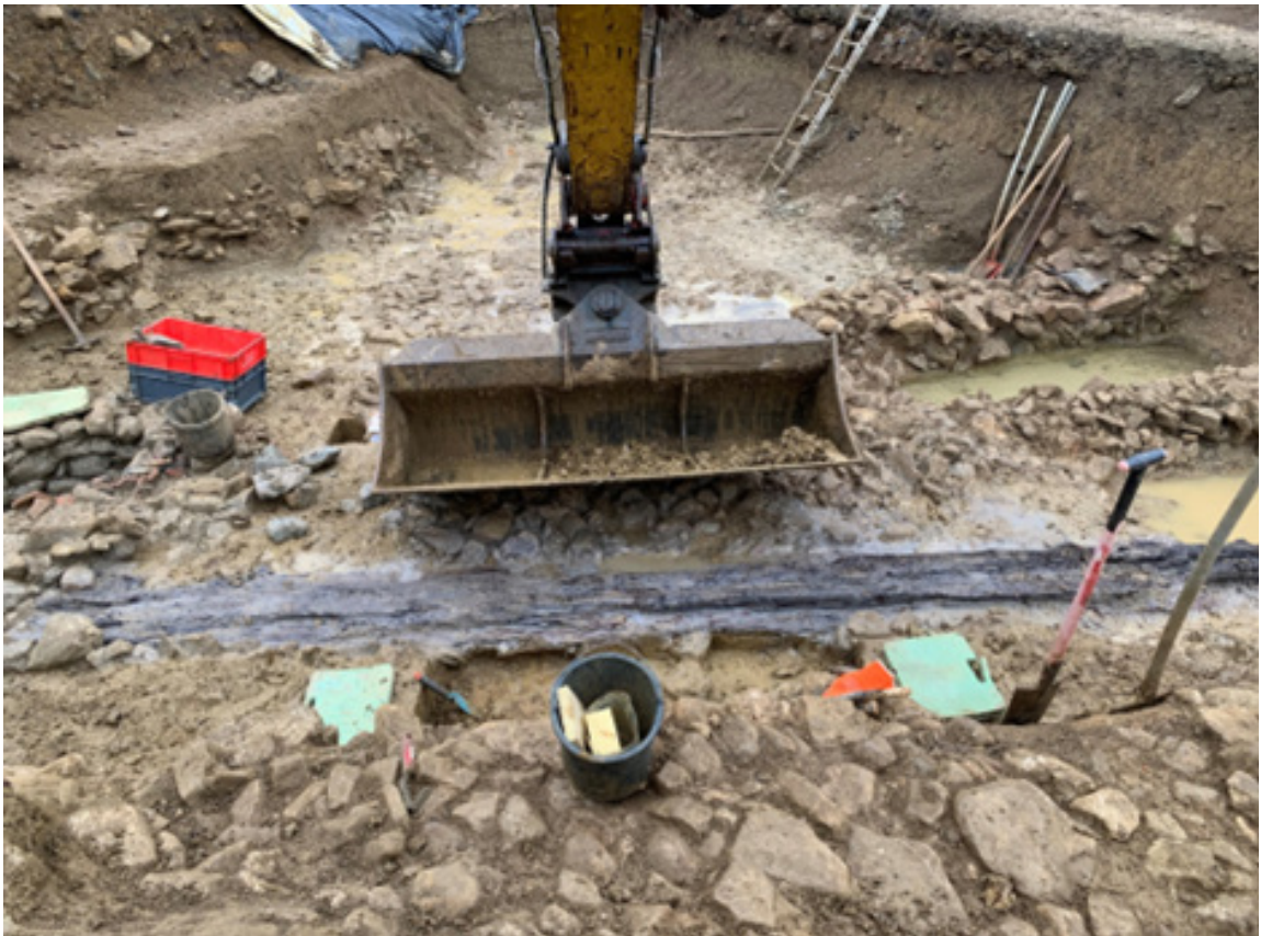
Photo 3 : les éléments en bois préservés sur le chantier de fouille de Mamer « Mameranus »
